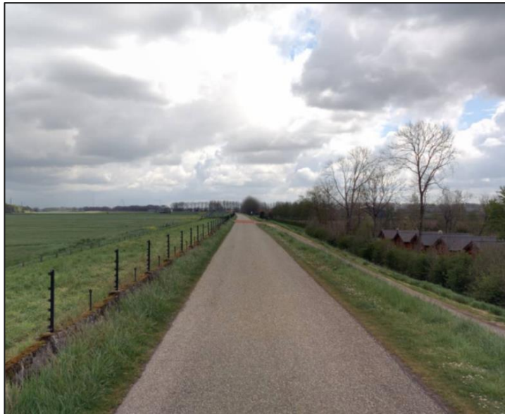
Figuur 3.2: Oostdijk ter hoogte van de camping
